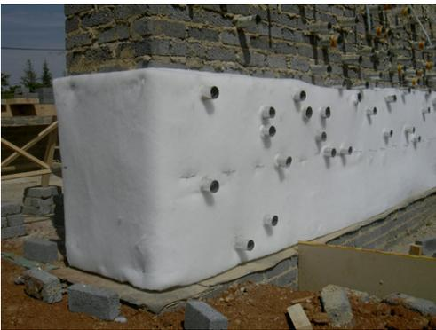
**Bild 3: Polyesterfaserdämmung**
