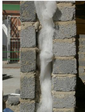
**Bild 4: 2-schaliges Mauerwerk**
